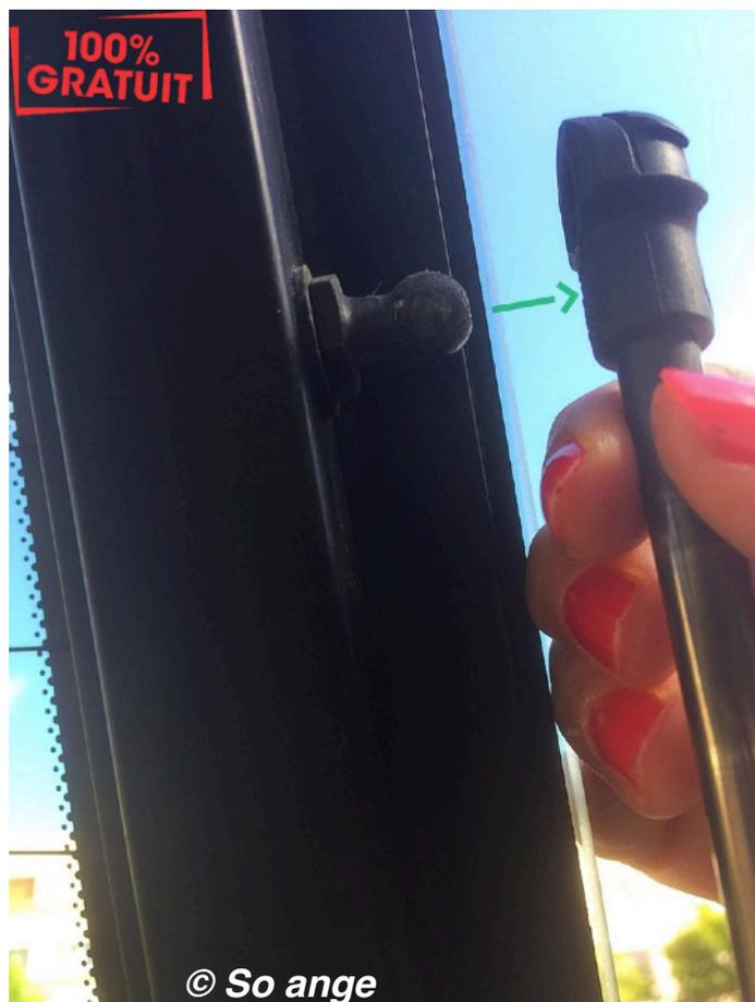
Nettoyez les rotules avec un chiffon. Saletés et poussières ont pu s'y accumuler. Les rotules doivent être propres avant d'accueillir un nouveau vérin.
